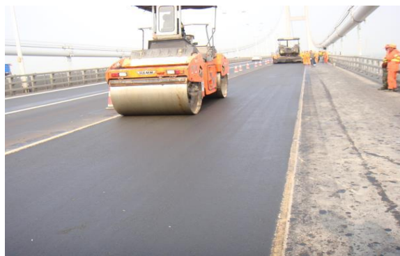
江苏润扬大桥施工现场
