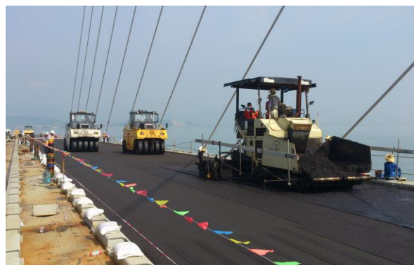
浙江象山大桥钢桥面施工
